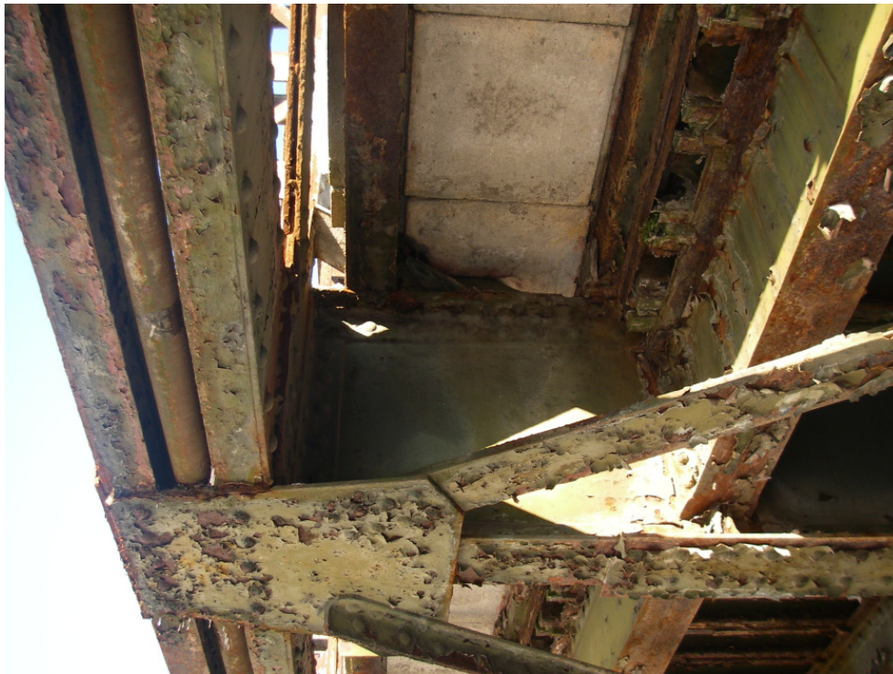
Bild 4 Fachwerkknoten unterer H-Verband mit Untergurt links und Fahrbahnträger rechts Links Trägerform des Fachwerkuntergurtes wie Bild 3b
